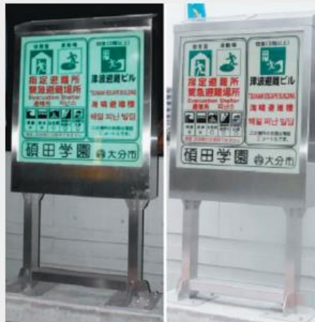
【右】蓄光板とLEDを組み合わせた避難誘導看板「ブルーインパクト」。上部に太陽光発電パネルを備えるため外部電源が要らない【左】蓄えたLEDの光エネルギーによって夜間に発光する。視認しやすい青緑色の光を採用した＝大分市の碩田学園南門
